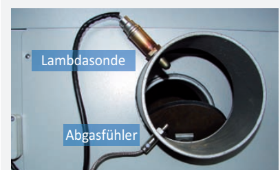
HVS LambdaControl: Permanente Verbrennungsoptimierung durch Abgasanalyse über die Lambdasonde und einstellbare Abgastemperatur
